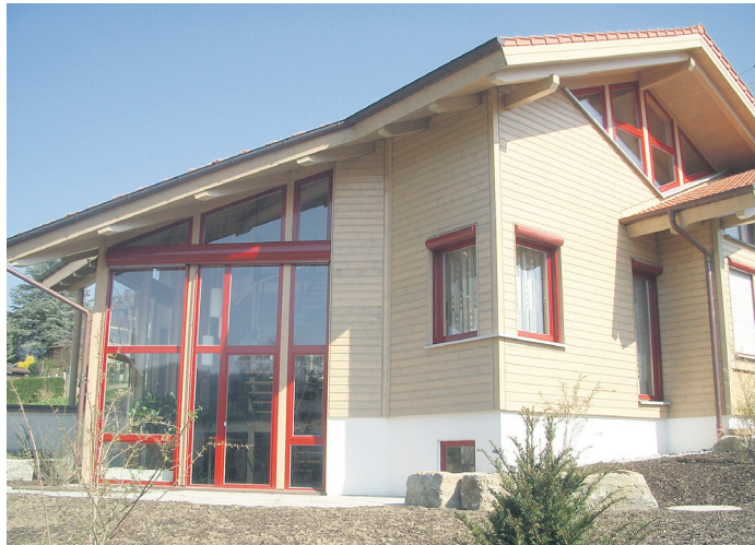
Ein Beispiel des Holzbauhandwerks von Schall ist dieses Holzhaus.
